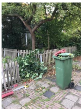
hier wordt gewerkt
